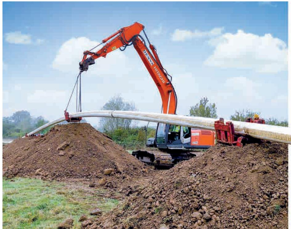
L'angle global du forage a permis de n'utiliser qu'un nombre limité de matériel pour manipuler la canalisation acier.
