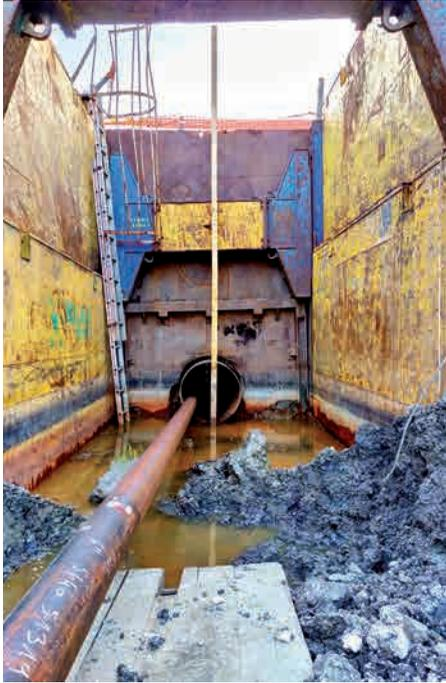
Le passage sous la route trop proche du puits de sortie pour permettre le stockage de la canalisation acier s'est fait par la technique du fonçage.
